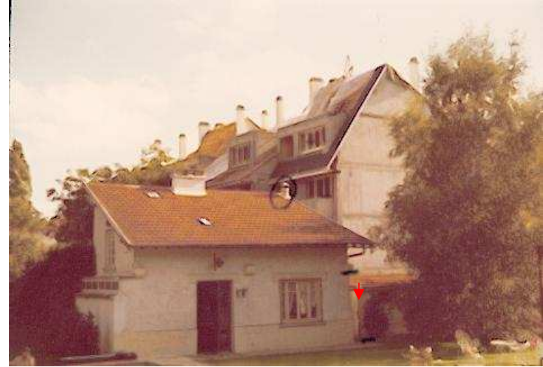
Bâti des Gentilhommières, construites en mitoyenneté sans respect des prospects ( Niveau bas à 2 mètres du sol, c'est à dire à la hauteur de la fenêtre de chambre)
